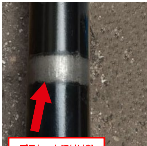
ブラケット取付け部
